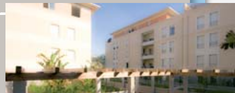
Nice - Pasteur Maccario - 26 logements loyer HC indicatif pour un T4 : 800 €
